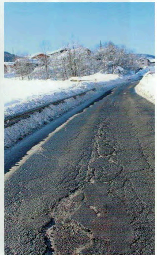
Sanierung von Straßen
