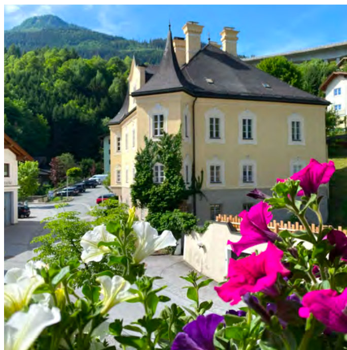
Das Dach des denkmalgeschützten Amtsgebäudes muss saniert werden.
