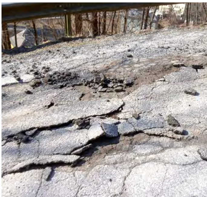
Der gefährliche Teil der Hangrutschungen der Böndlseestraße wurde verbaut.
