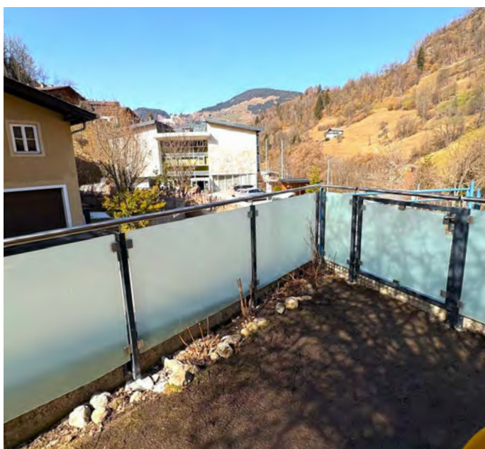
Die Zäune beim Kindergarten Lend und dem Recyclinghof mussten erneuert werden.
