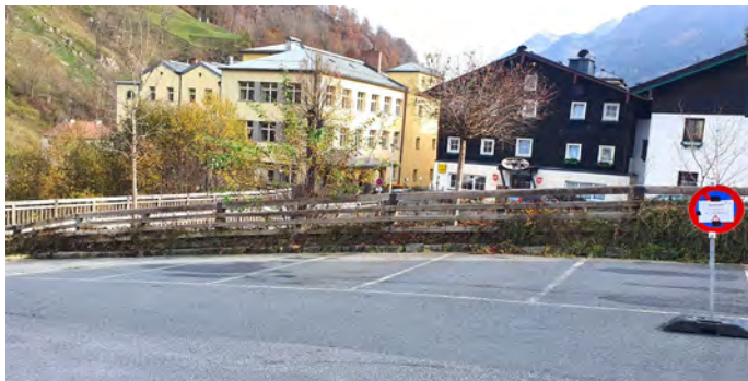
Markierungsarbeiten bei den Parkplätzen.
